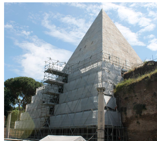
foto 5 / (©Francesca Pontani) Le due colonne rialzate con il restauro del 1663 (maggio 2014)
