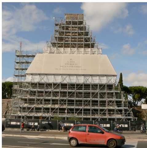
foto 1 / (©Francesca Pontani) Piazzale Ostiense con l'inizio dei lavori di restauro della Piramide (2013)
